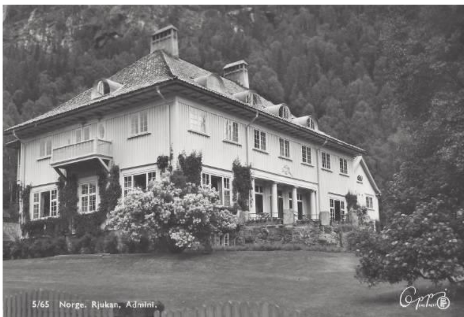
Admini Rjukan, Hydros administrasjonsbolig. Rjukan ble grunnlagt av Sam Eyde og Norsk Hydro.
